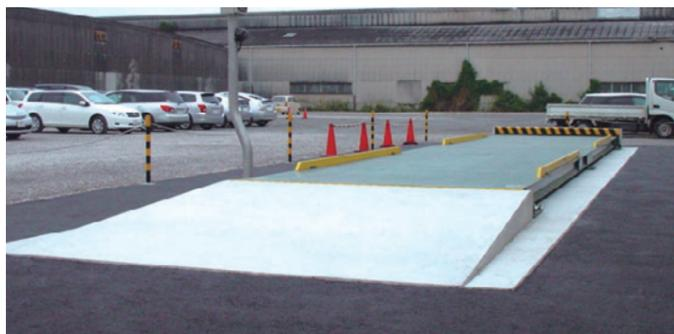
コンクリート製スロープ築造タイプ
