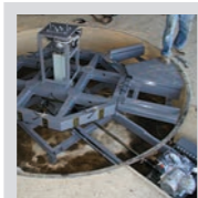
テーブル設置
