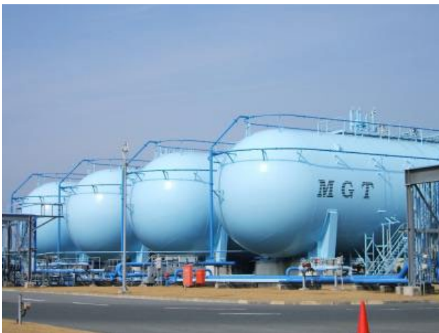
【美しい水色の外観をした貯槽】
